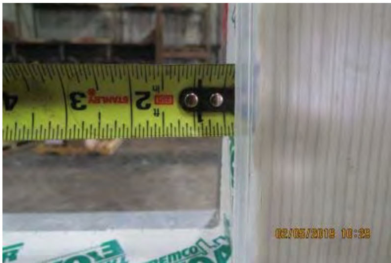
Photo No. 8 TREMCO PROGLAZE ETA
